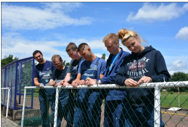
Hier wird der für die Sicherheit wichtige Drahtzaun am Sportplatzgeländer von den Azubis befestigt. Foto Paula7
