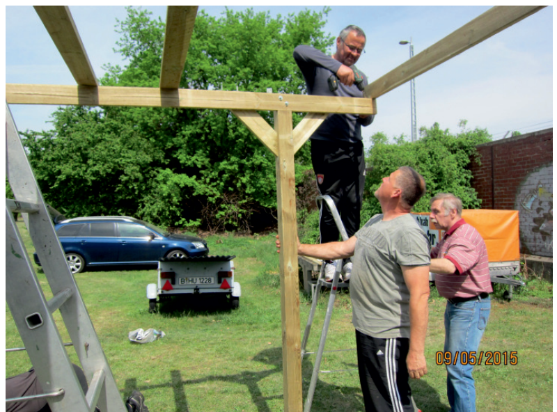
An der Überdachung des Schießstandes für Sportfeste wird fachmännisch gebaut
