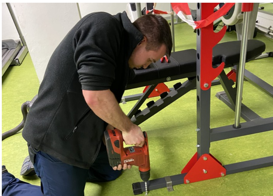
Stephan Gräfe (Abt. Fitness) bohrt das letzte Loch für die Befestigung der neuen Multipresse im Fitnessraum. Mit diesem Gerät wird das Arsenal der Möglichkeiten zur Verbesserung der Fitness erweitert. Weitere Informationen s. S.4
