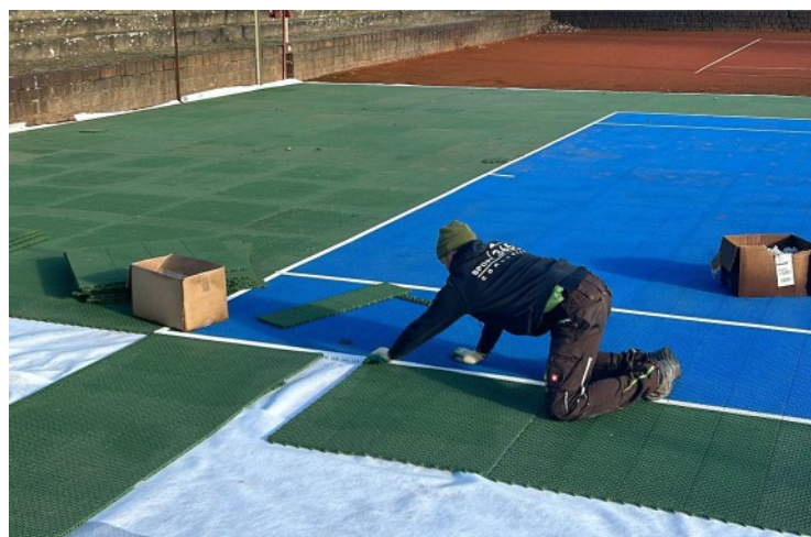
Der Flexcourt wird auf einer fließartigen Zwischenlage verlegt.
