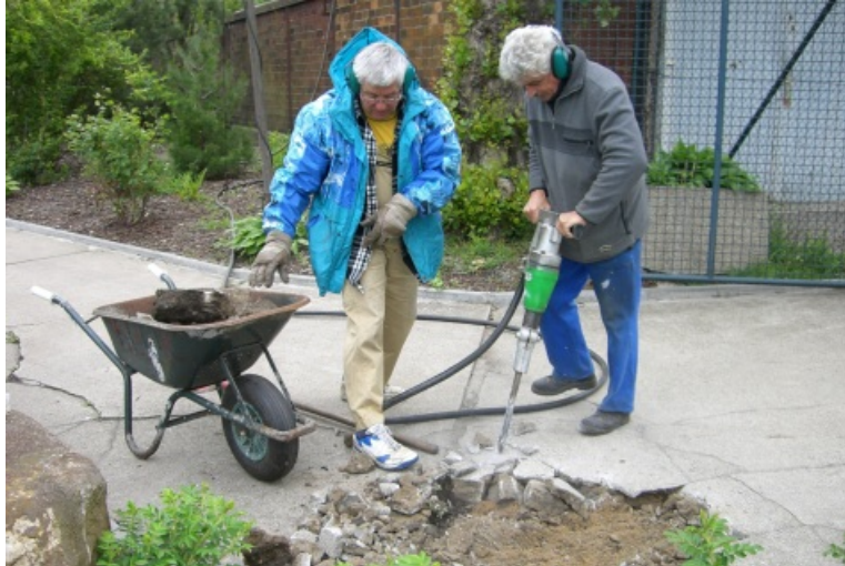
Jürgen Schulz beginnt mit dem Zertrümmern des Eingangsweges.
