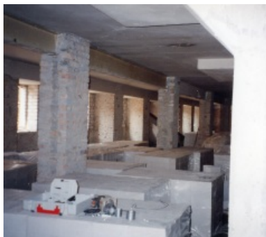
Entkernter Keller: Hier entstanden Schießstände
