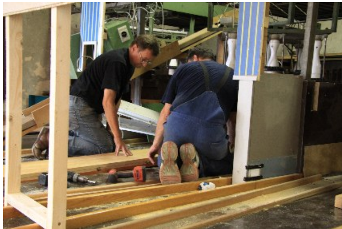
Lange Zeit mussten Arbeiten im Knien erledigt werden.
