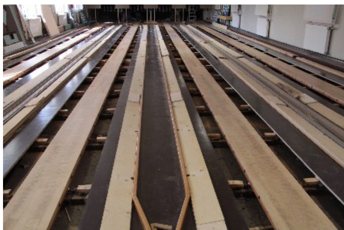
Die neue Bohle ist ausgelegt.
