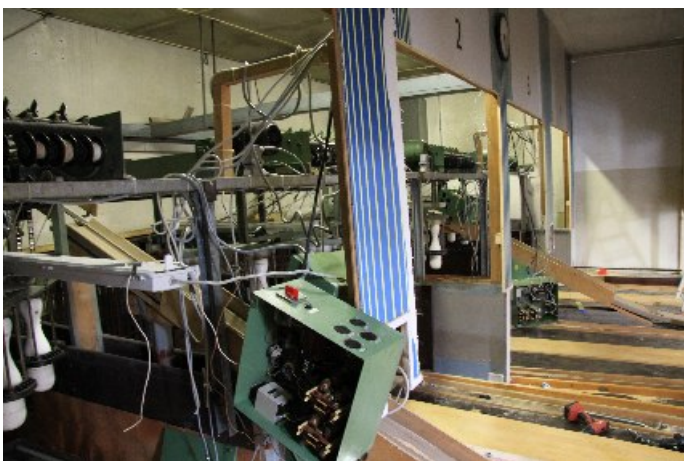
Nach dem Abbau der Anzeige entstand erst mal ein Kabelgewirr.
