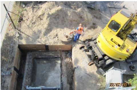
Ein Blick in die Baugrube für den Aufzug.
