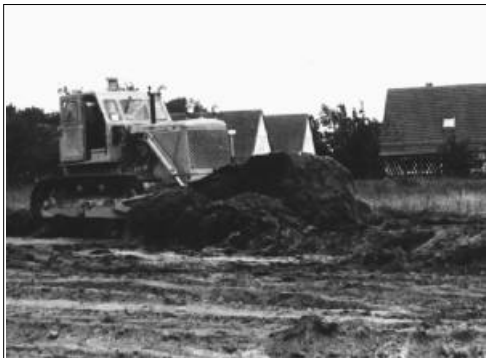
Die Voraussetzung für das Sporttreiben mit den Hunden werden geschaffen. 1974 ebnet eine Planierdrape den Übungsplatz und schiebt die Erde für die Zuschauertraversen zusammen
