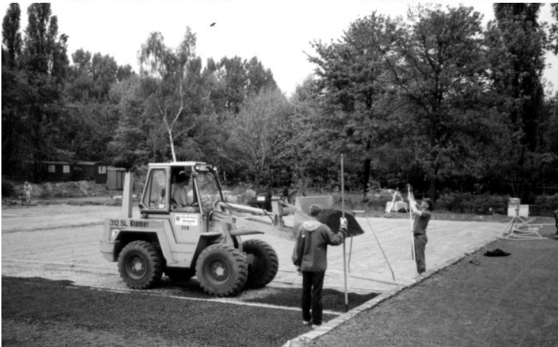
Die Firma Fröhner beim Einbringen des Untergrundes aus Lava auf Platz 5
