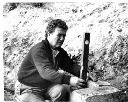
Baumeister / Bauleiter Wolfgang Hampel hat viele Baustellen auf unserer Tennisanlage „in den Griff bekommen“. Hier setzt er den ersten Stein an der Platzbegrenzungsmauer beim Neubau der Tennisplätze 1981-1983. Es sollten am Ende mehr als 5000 Pflastersteine werden
