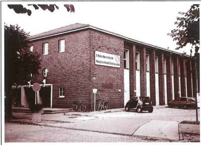
Die Lok-Sporthalle Adlgestell Nr. 143, direkt vor der Hauptwerkstatt der S-Bahn Berlin GmbH.
